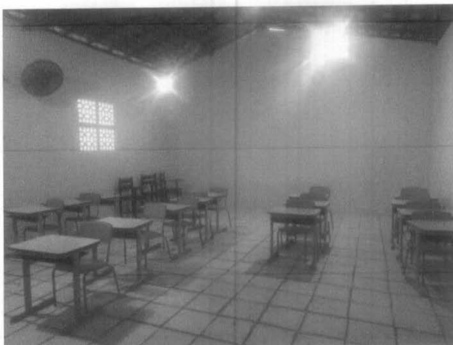
Imagem 9 -- Recuperação de reboco interno e pintura interna da escola.
