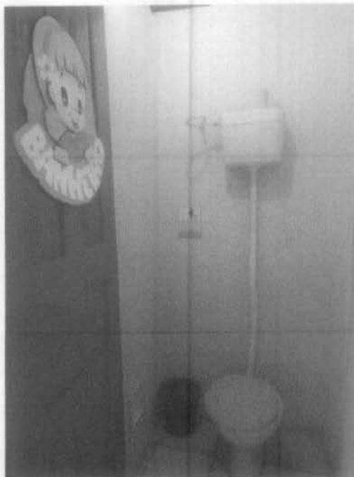
Imagem 5 – Revisão nos pontos hidráulicos e sanitários.
