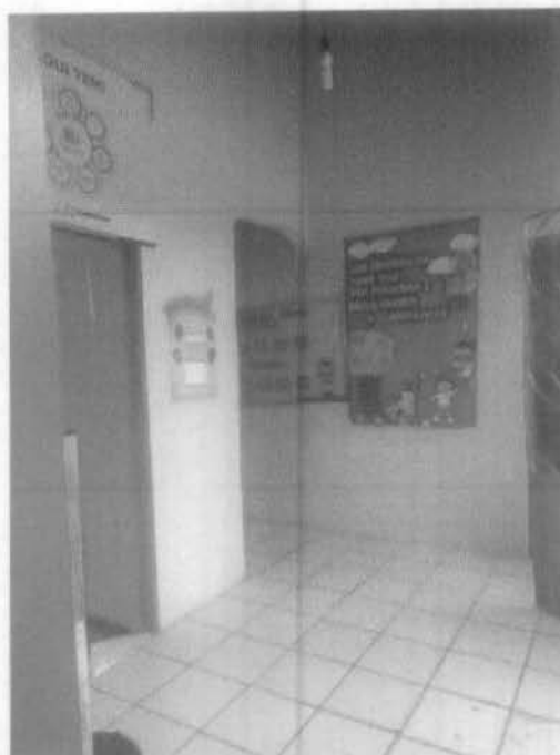
Imagem 3 – Pintura interna e pintura das esquadrias da escola.
