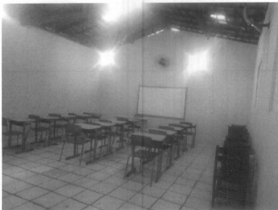
Imagem 8 – Recuperação de reboco interno e pintura interna da escola.
