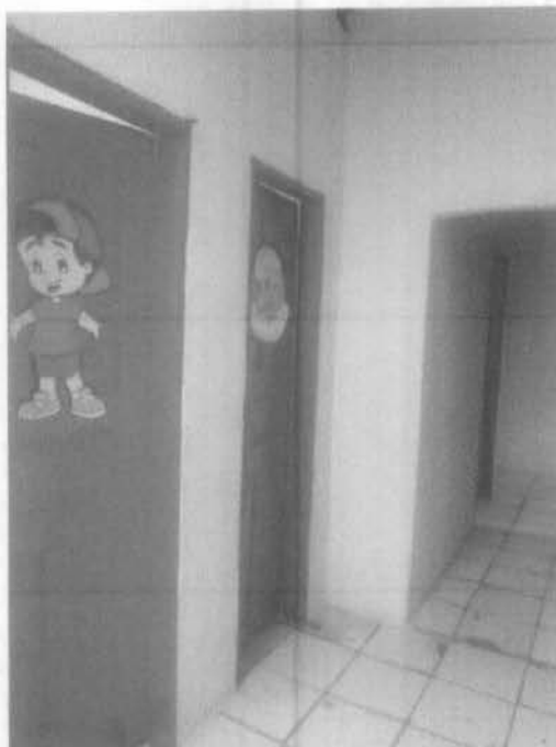
Imagem 7 – Recuperação de reboco interno e pintura interna e pintura das esquadrias da escola.
