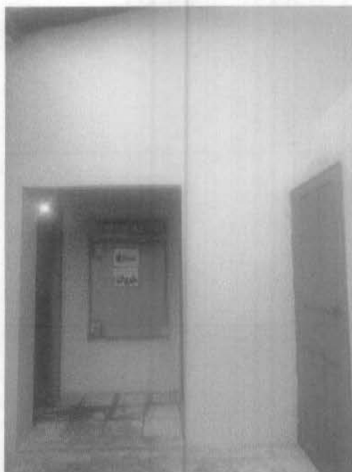
Imagem 6 – Recuperação de reboco interno e pintura interna da escola.
