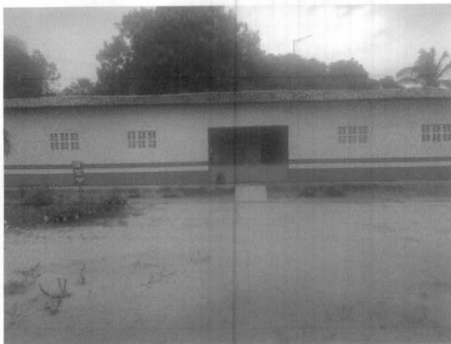
Imagem 1 – Recuperação de reboco externo e pintura da fachada da escola.
